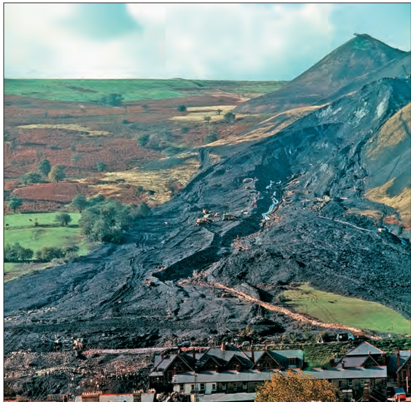
Оползень-поток в Аберфане. Октябрь 1966 г.
