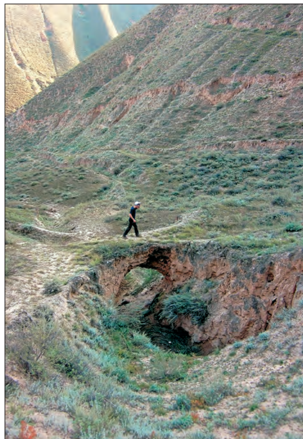
Псевдокарстовый мост, сохранившийся на одном из самых прочных отрезков бывшего тоннеля.
